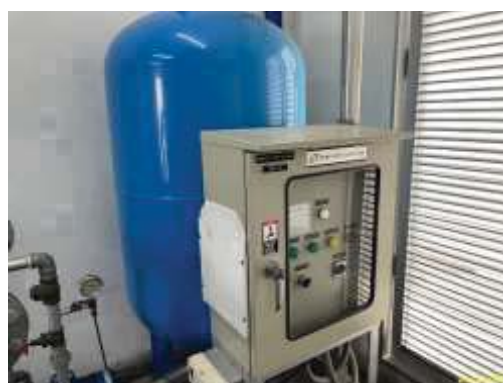
ถังเก็บน้ำชั้นดาดฟ้า พร้อมเครื่องปั๊มน้ำ
