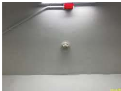
เครื่องตรวจจับควัน (Smoke Detector; SD)
