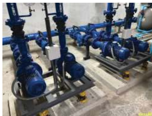
พื้นที่ถังเก็บน้ำใต้ดิน พร้อมเครื่องสูบน้ำ
